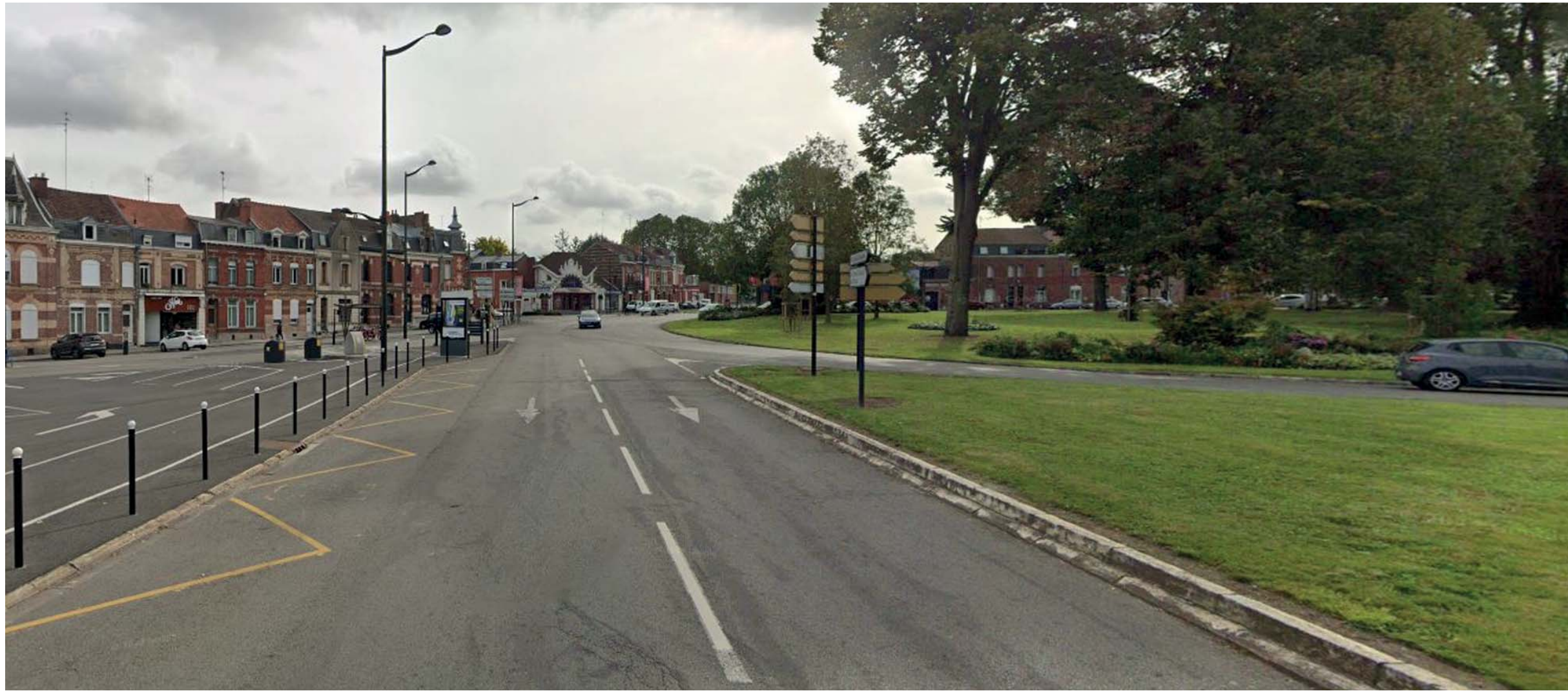
Existant : Vue vers le Boulevard Carpeaux depuis le Boulevard Saly
