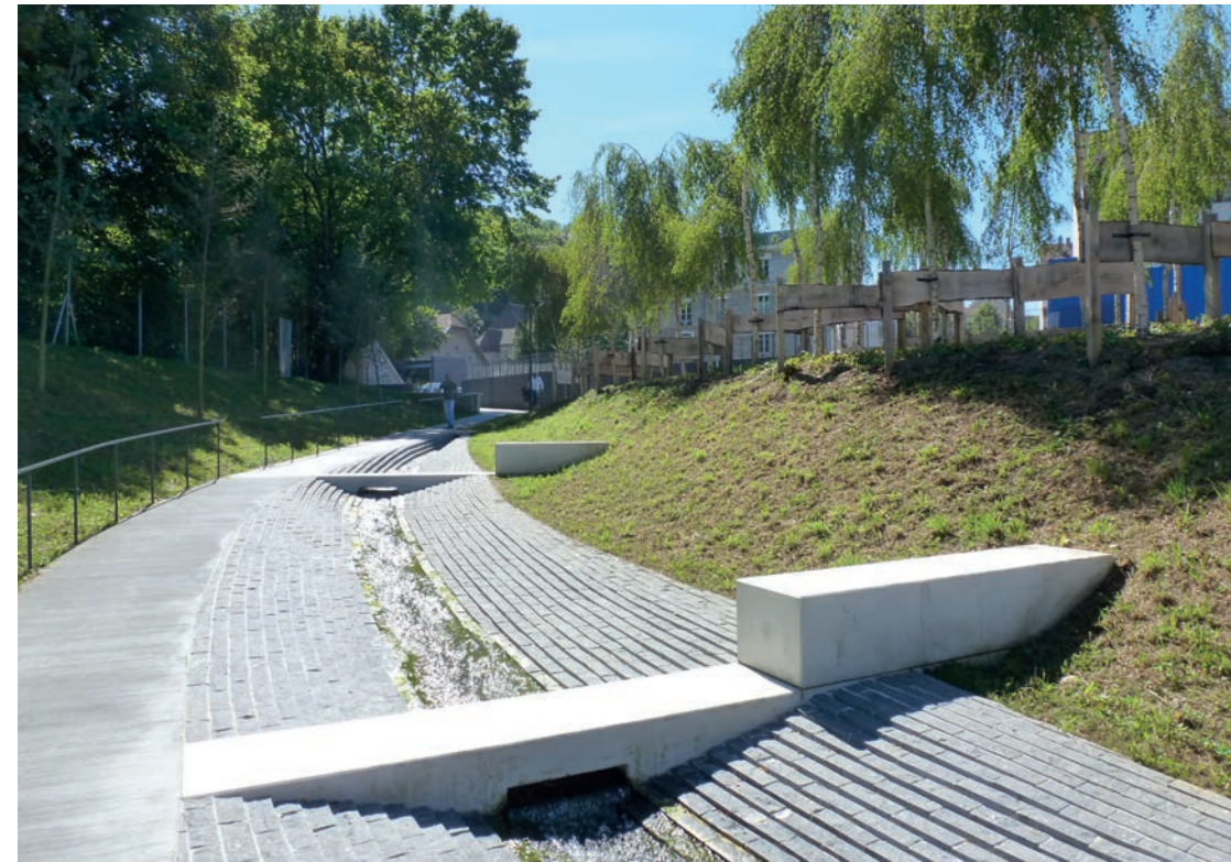
2 Acheminement des eaux dans un escalier d'eau maçonné le long de la promenade.
