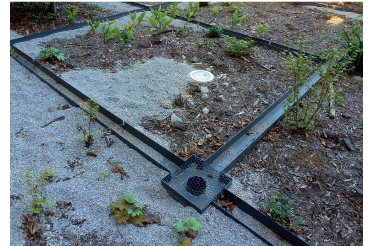
5 Système de distribution des eaux de toiture sur le jardin de l'harmonie.
