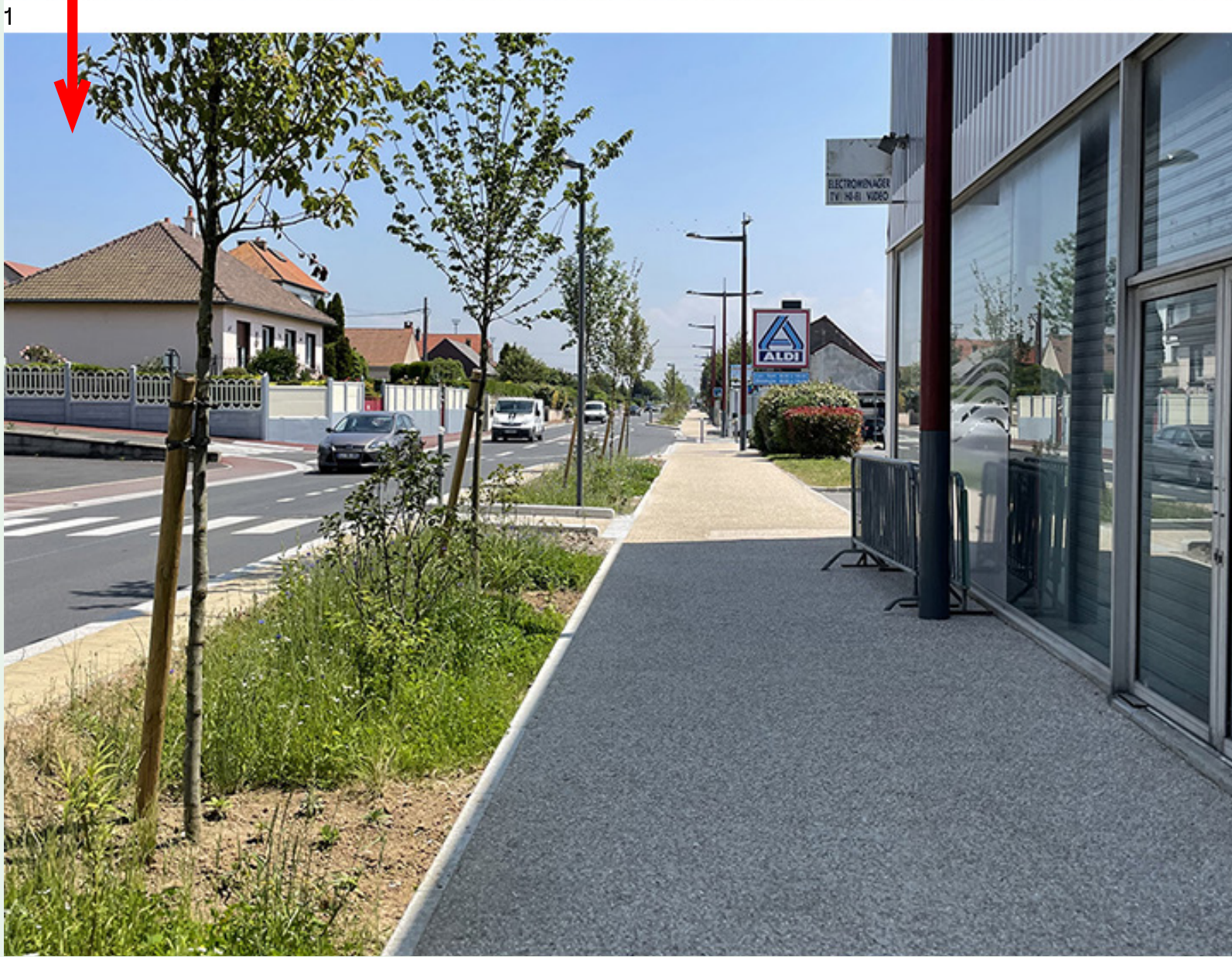
1 Large voie verte séparée de la voirie par une noue multi-strates recueillant les EP
