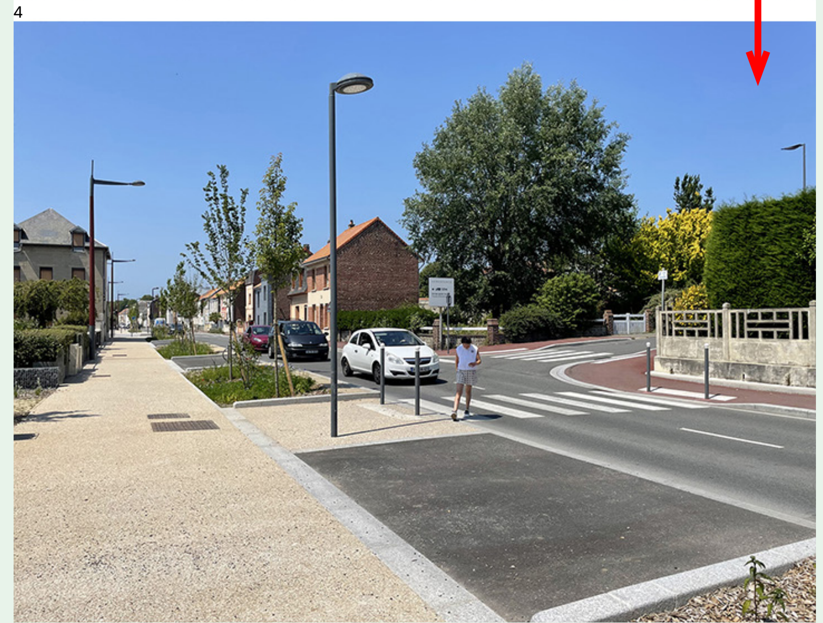
4 Renforcement des traversées piétonnes et sécurisation des usagers
