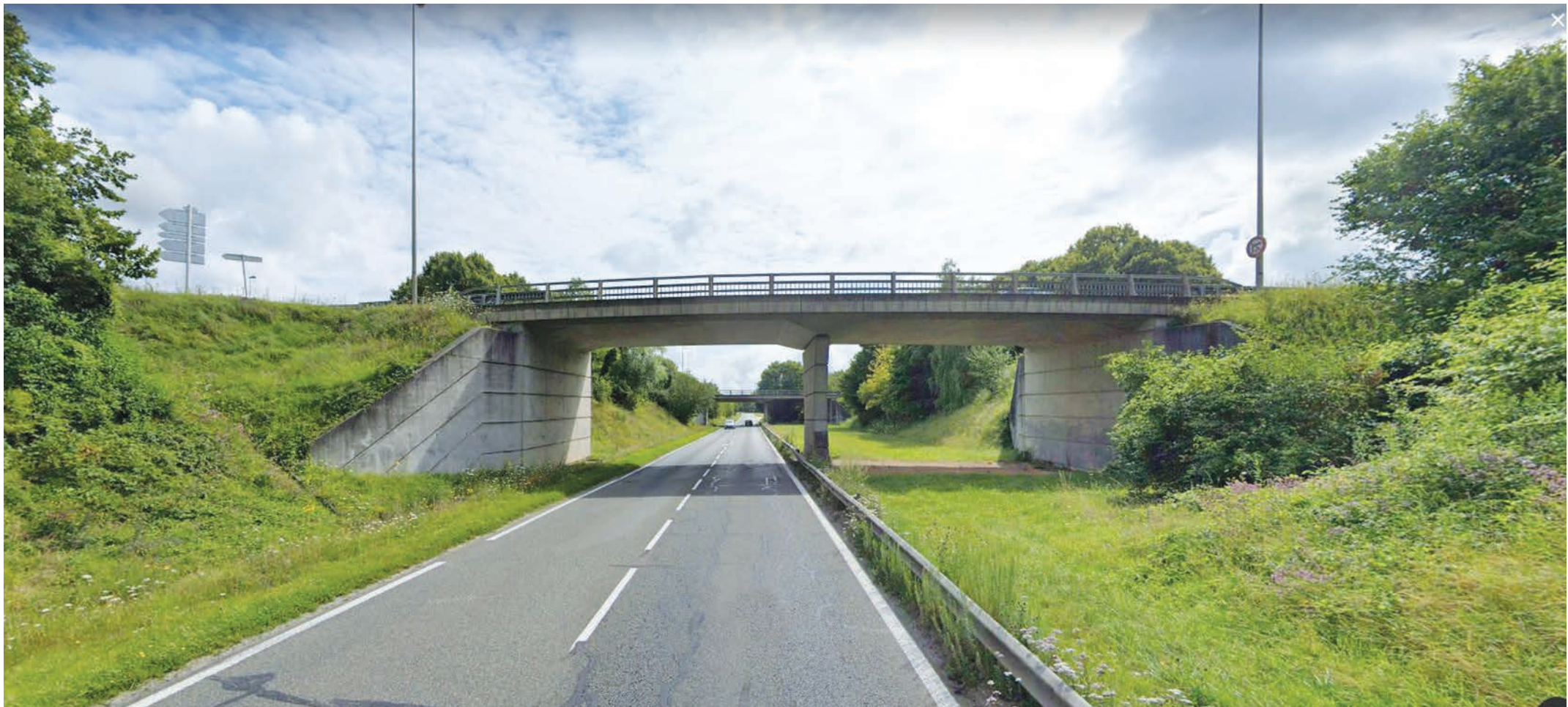
VUE DEPUIS LA RD 201 VERS SENLIS - ÉTAT EXISTANT
